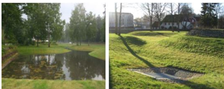
Figur 17. Skålade/nedsänkta grönytor vid vått respektive torrt väder. Observera att Djupet på den skålade ytan i bilderna är mycket större än de föreslagna 10–15 cm i denna utredning.
